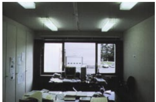
Fig. 58: Slechte lichtprestaties met opaline afschermkappen (PROBE, vóór renovatie).
