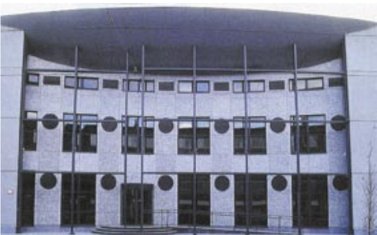
Fig. 1: Het administratiefgebouw van de intercommunale IVEG in Hoboken: een voorbeeld van een no-nonsenseaanpak voor een klein kantoorgebouw. Het geeft blijk van een geïntegreerde aanpak van het ontwerp op basis van een programma van eisen met grote aandacht voor binnenklimaat en energiegebruik.
