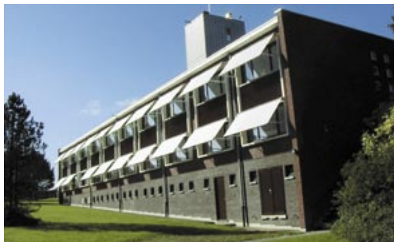
Fig. 2: Het PROBE-gebouw van het WTCB in Limelette: een bescheiden kantoorgebouwtje uit de jaren 70 wordt opgewaardeerd door een reeks van pragmatische renovatiemaatregelen. De werkvoorwaarden (comfort, ...) gaan er sterk op vooruit en het energiegebruik daalt. Al richt deze brochure zich in de eerste plaats op nieuwbouw, veel van de voorgestelde principes kunnen ook worden toegepast op renovatieprojecten.
