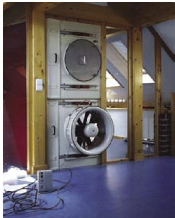
Fig. 17: Meting van de gebouwluchtdichtheid gebeurt met een opblaasproef: met een grote ventilator wordt het gebouw in overdruk geplaatst en wordt het luchtdebiet gemeten dat nodig is om de lekverliezen te compenseren.
