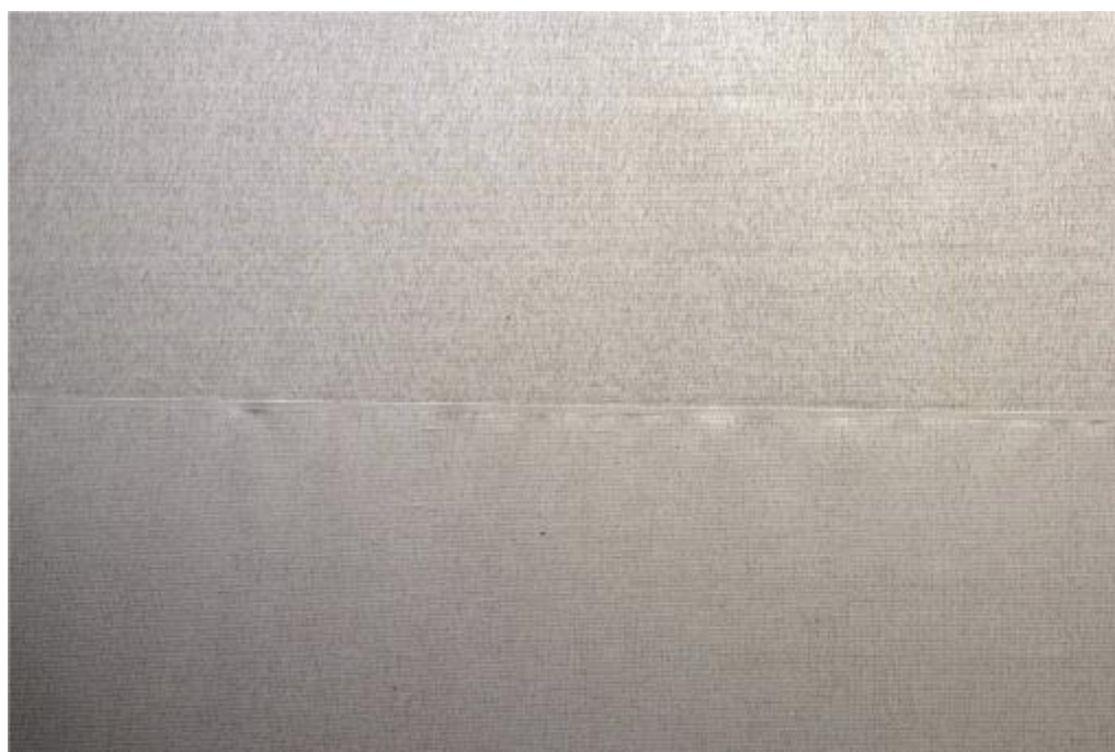
Afb. 9.4.2 Toelaatbare plooivorming bij zipsystemen bij de naden en zomen
