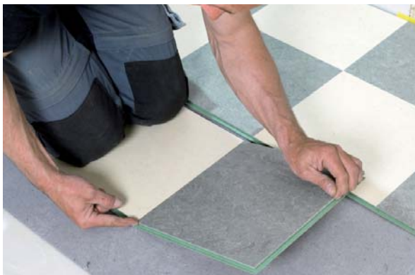
Plaatsen van linoleum
