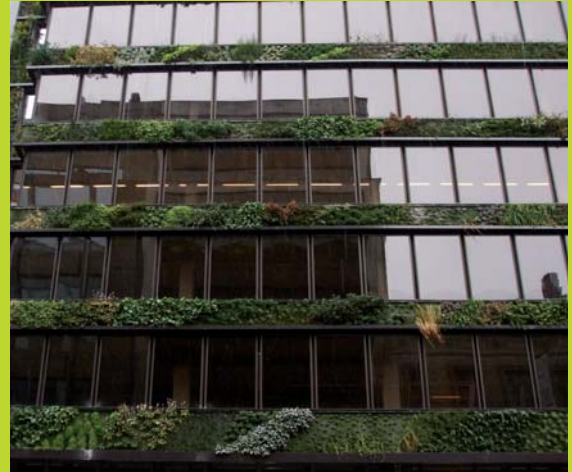
Bouwwerf Belliardstraat, Brussel. De Ondernemingen Jacques Delens.
