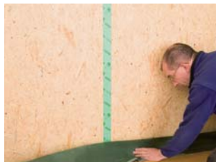
Luchtdichtheidstape voor verbinding muur-vloer
