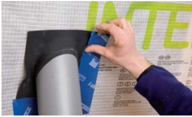
Luchtdichtingsmanchette voor leidingdoorvoeren
